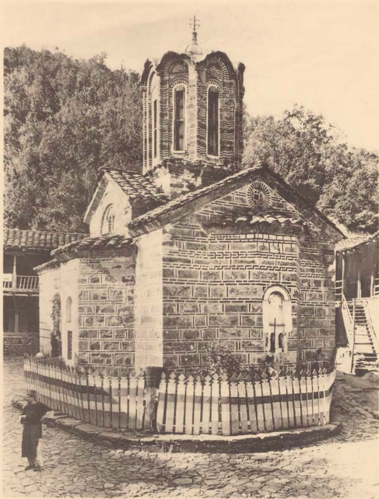
141. Kučevište. Le Saint-Archange. Abside et façade méridionale. (Phot. Le Tourneau).
